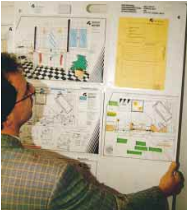
Diese projektspezifischen Montagetafeln werden auf der Baustelle angebracht. Sie sind mit allen Informationen für die verschiedenen Gewerke bestückt, die im Bad arbeiten
